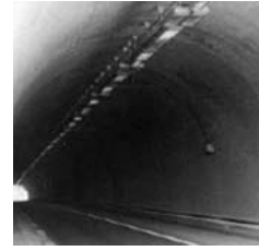
Fig 10.1.1 a.2. — Túnel abovedado estrecho, la fila puede estar desplazada lateralmente encima de la vía rápida (distancia de seguridad a luminarias 0,10 m)
